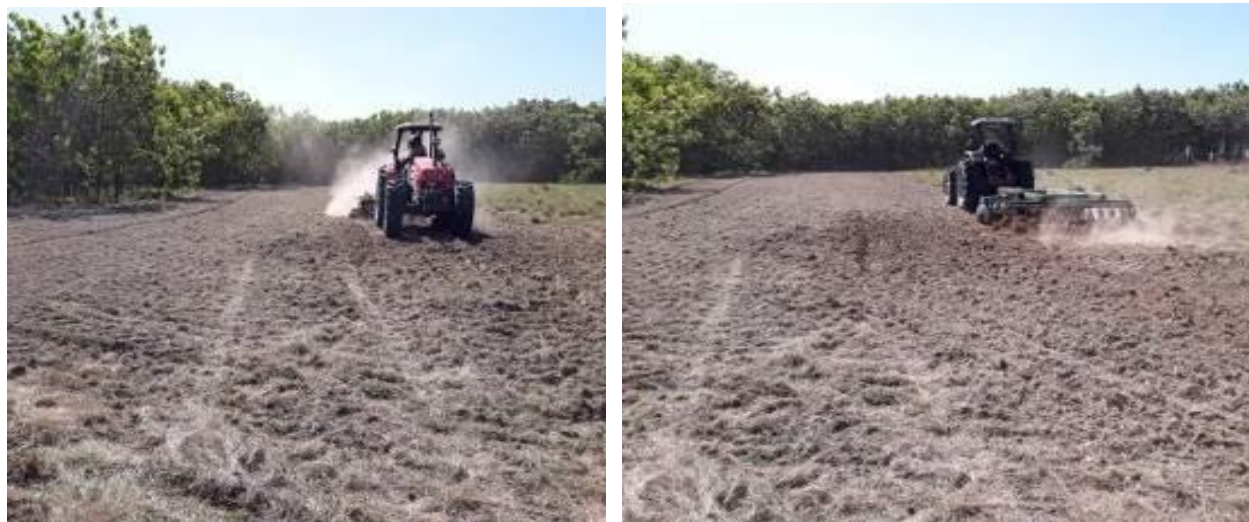
ILUSTRACIÓN 8. MANTENIMIENTO DE BARRERAS CORTA FUEGOS.
